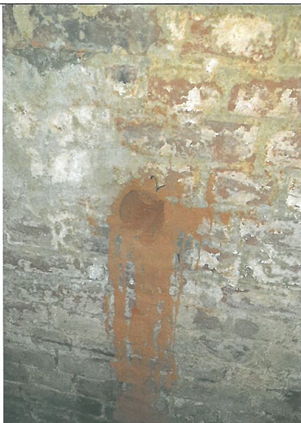
Zonă prelevare carota C 2 Element vertical Subsol
